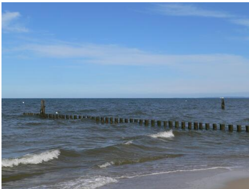
Eine der unzähligen gleich gestalteten Buhnen. Die Gefahr, darauf auszurutschen und neben oder zwischen die Buhnen zu stürzen, ist bei Betreten erheblich.
