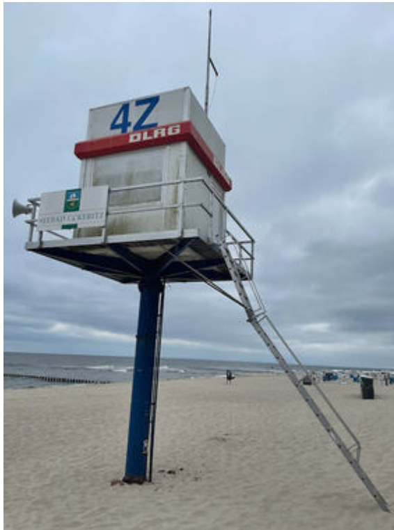
Westturm mit Leiter. Auch hier ist der Anstellwinkel zu flach, so dass sich die Leiter beim Besteigen durchbiegt.
