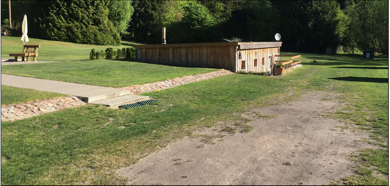
Abbildung 1: Blick auf Kellergeschoss des ehemaligen Küchengebäudes (Foto: 08.05.2018, BAUKONZEPT Neubrandenburg GmbH)
