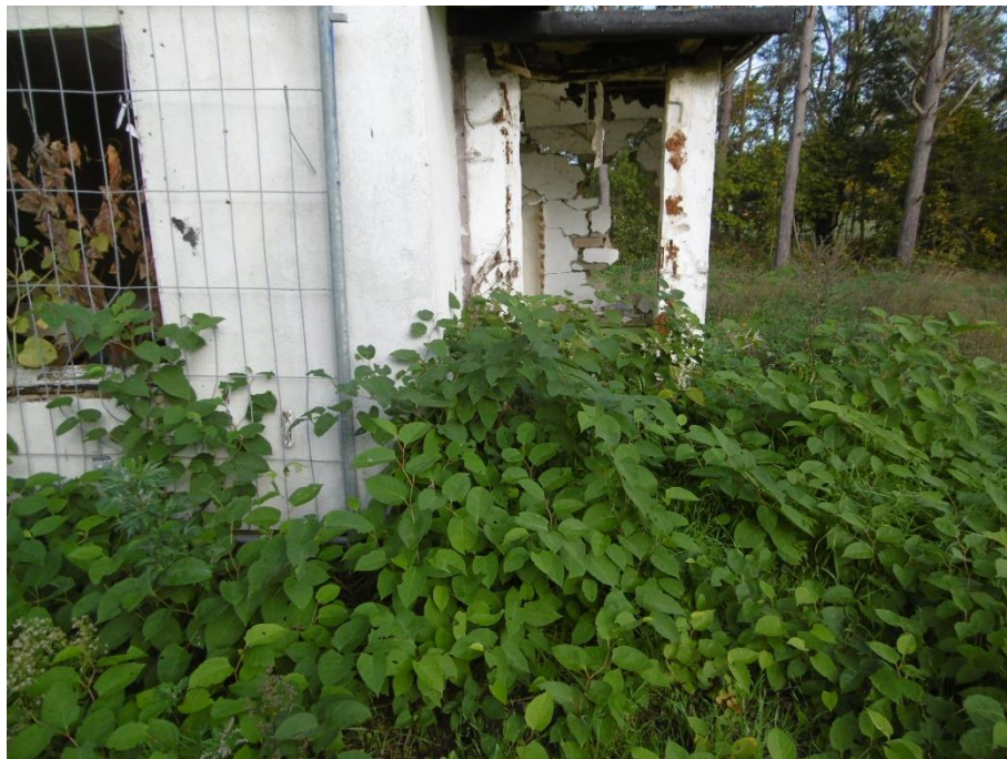
Foto 5: Im Zuge der Auflassung des Gebäudebestandes haben sich im Umfeld flächenhaft Neophyten-Staudenfluren mit Japanischem Staudenknöterich entwickeln können. Es handelt sich hierbei um eine invasive Pflanzenart.
