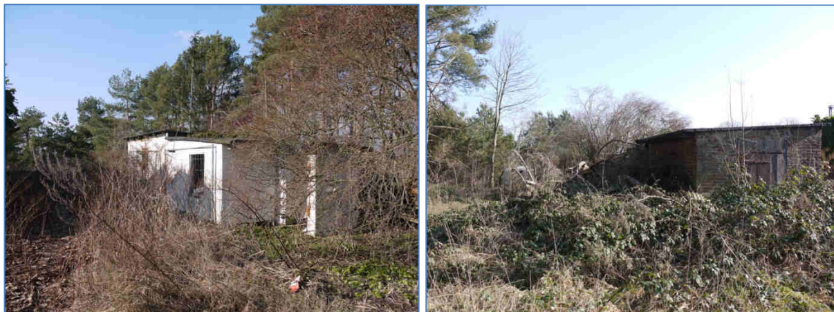
Abb. 8 und 9 Weitere Ansichten des ruinösen Gebäudebestandes und teilweise verbuschtes Freigelände.
