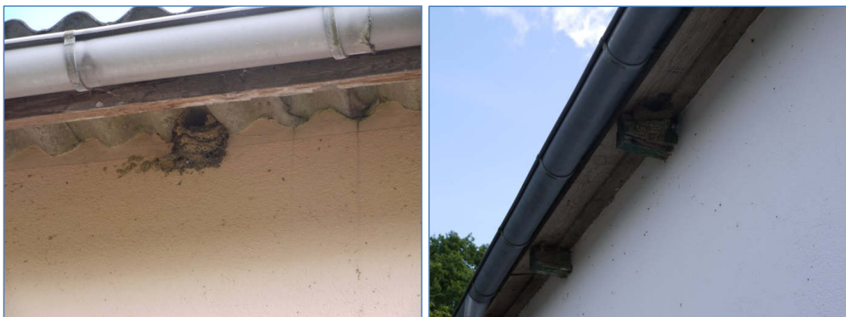
Abb. 14 und 15 Mehlschwalbennester an einem Bestandsgebäude.
