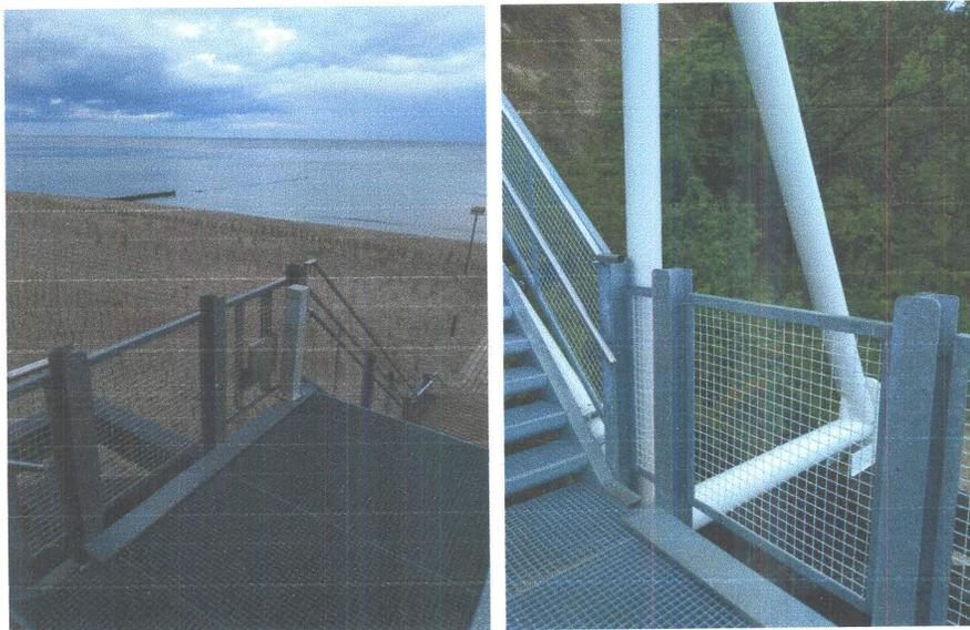
Sowohl der der Übersteigschutz als auch der Handlauf wurden auf dem Podest mit + 6,62 m OK Gitterrost demontiert und gestohlen.
