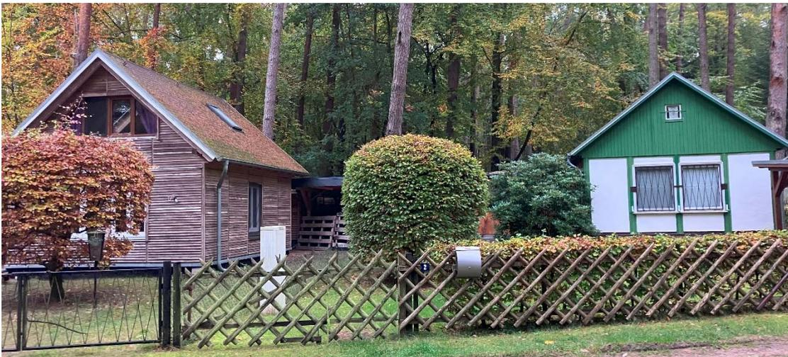
Foto 11 Beispiel für Dachneigung bis 48° (linkes Haus)
