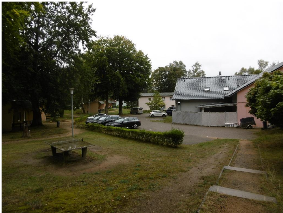
Foto 2: Blick von Osten auf das Mehrzweckgebäude und auf die von älteren Buchenbeständen, Rasenvegetationen, Stellplätzen für Pkw sowie Spiel- und Sportanlagen geprägten Freiflächen.
