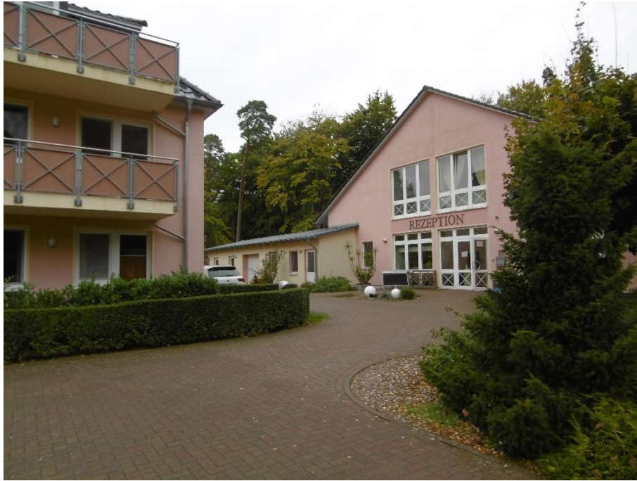
Foto 1: Blick auf das Rezeptionsgebäude und ein Bettenhaus. Die Zuwegungen sind gepflastert. Die Freiflächen sind mit Hecken, Strauch- und Gehölzanpflanzungen gestaltet.
