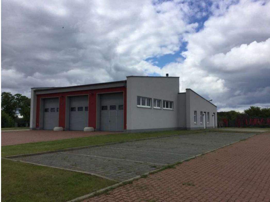
Abbildung G.2 – Außenansicht Feuerwehrhaus der Gemeindefeuerwehr Rankwitz
