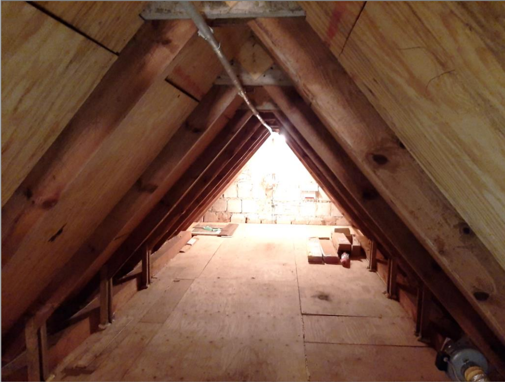
Abbildung 4: Dachboden Wohnhaus Nr. 31 ohne Nutzungshinweise, Quartierpotenziale zwischen Holzverschalung und Dachhaut möglich
