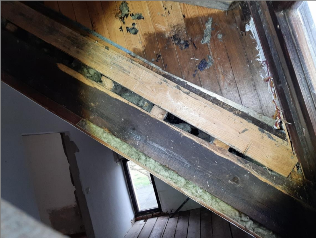
Abbildung 8: Dachboden Wohnhaus Nr. 32 ohne Nutzungshinweise, potenzial nutzbare Strukturen im Bereich der Holzverschalung
