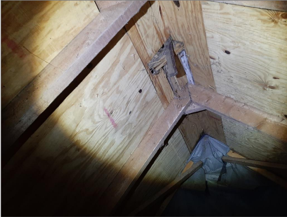
Abbildung 6: Dachboden Wohnhaus Nr. 31 ohne Nutzungshinweise, Quartierpotenziale zwischen Holzverschalung und Dachhaut möglich
