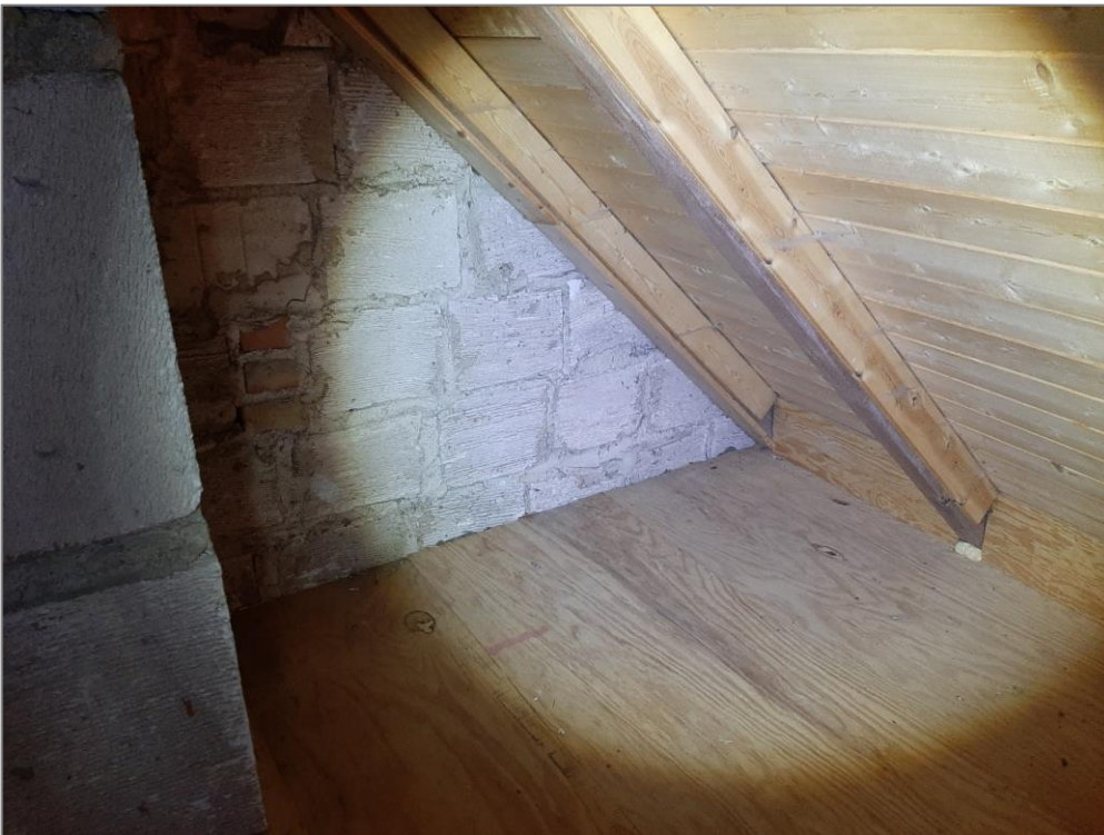
Abbildung 5: Dachboden Wohnhaus Nr. 31 ohne Nutzungshinweise, Quartierpotenziale zwischen Holzverschalung und Dachhaut möglich
