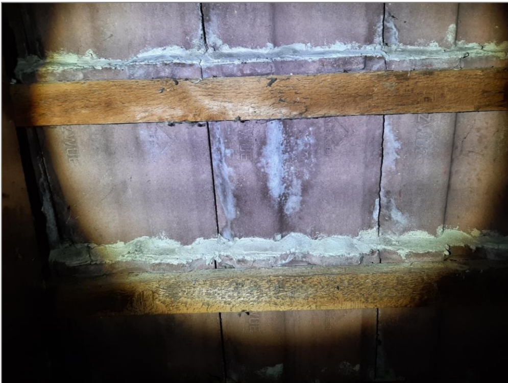
Abbildung 7: Dachboden Wohnhaus Nr. 32 ohne Nutzungshinweise, Quartierpotenziale unter den Dachziegeln unwahrscheinlich
