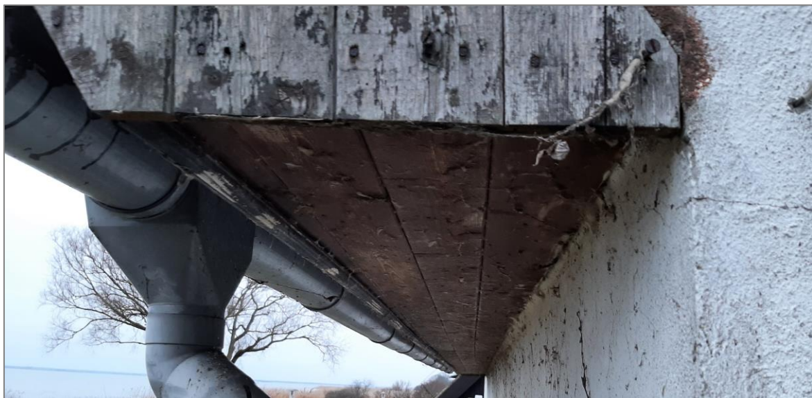
Abbildung 3: Dachkasten Wohnhaus Nr. 32 ohne erkennbar Einflugmöglichkeiten
