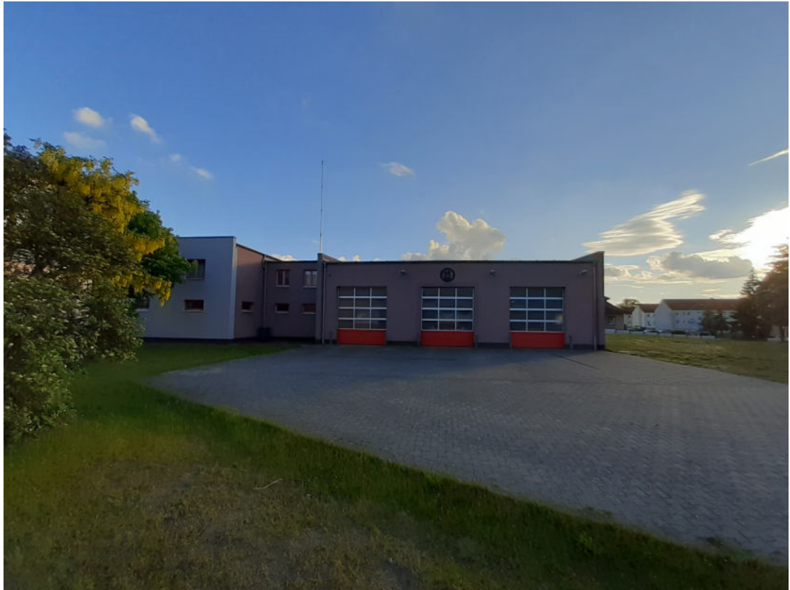
Abbildung G.2 – Außenansicht Feuerwehrhaus der Gemeindefeuerwehr Usedom
