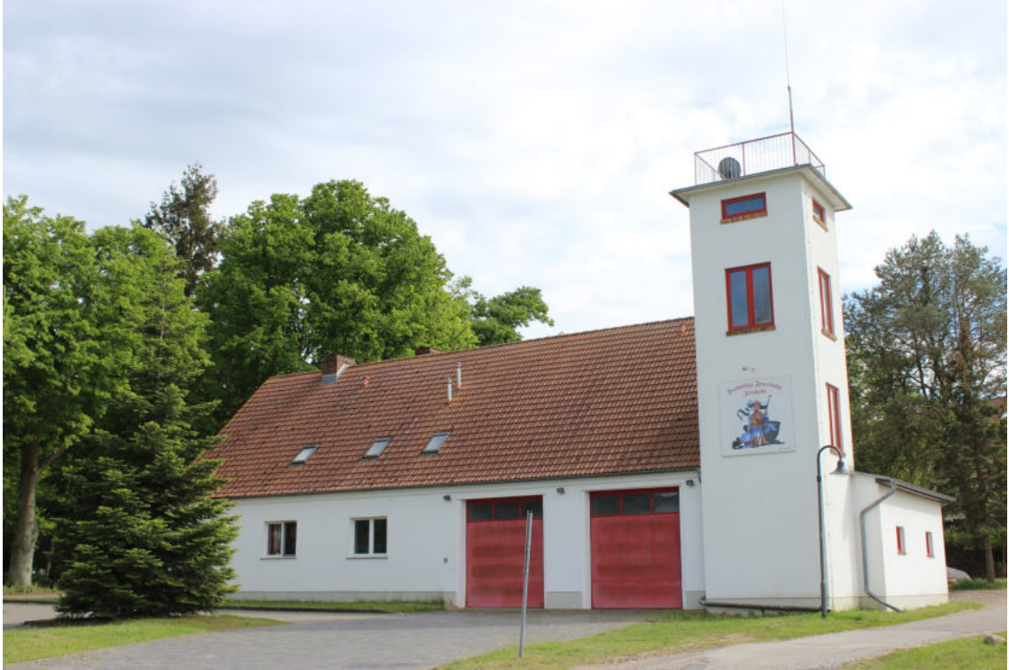
Abbildung G.2 – Außenansicht Feuerwehrhaus der Gemeindefeuerwehr Zirchow
