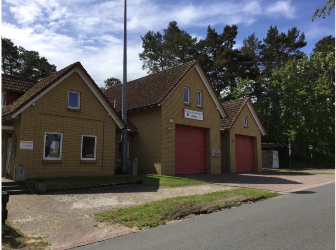
Abbildung G.2 – Außenansicht Feuerwehrhaus der Gemeindefeuerwehr Loddin
