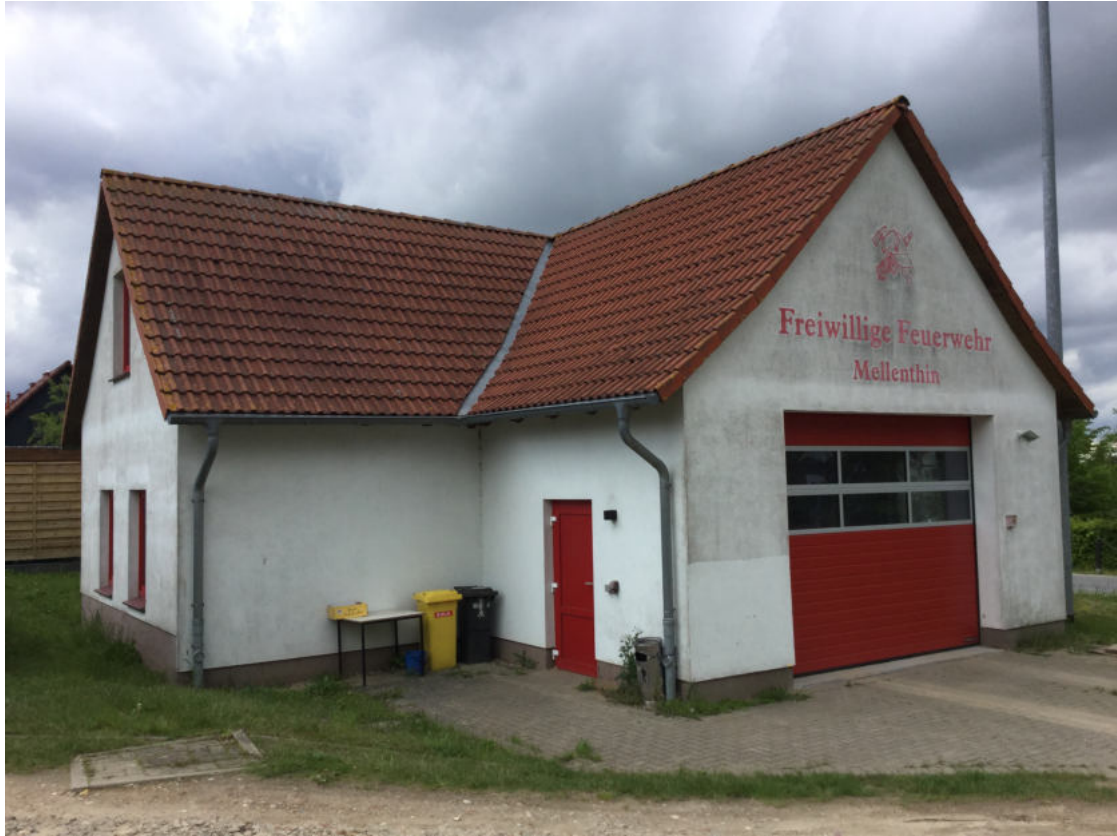
Abbildung G.2 – Außenansicht Feuerwehrhaus der Gemeindefeuerwehr Mellenthin-Morgenitz
