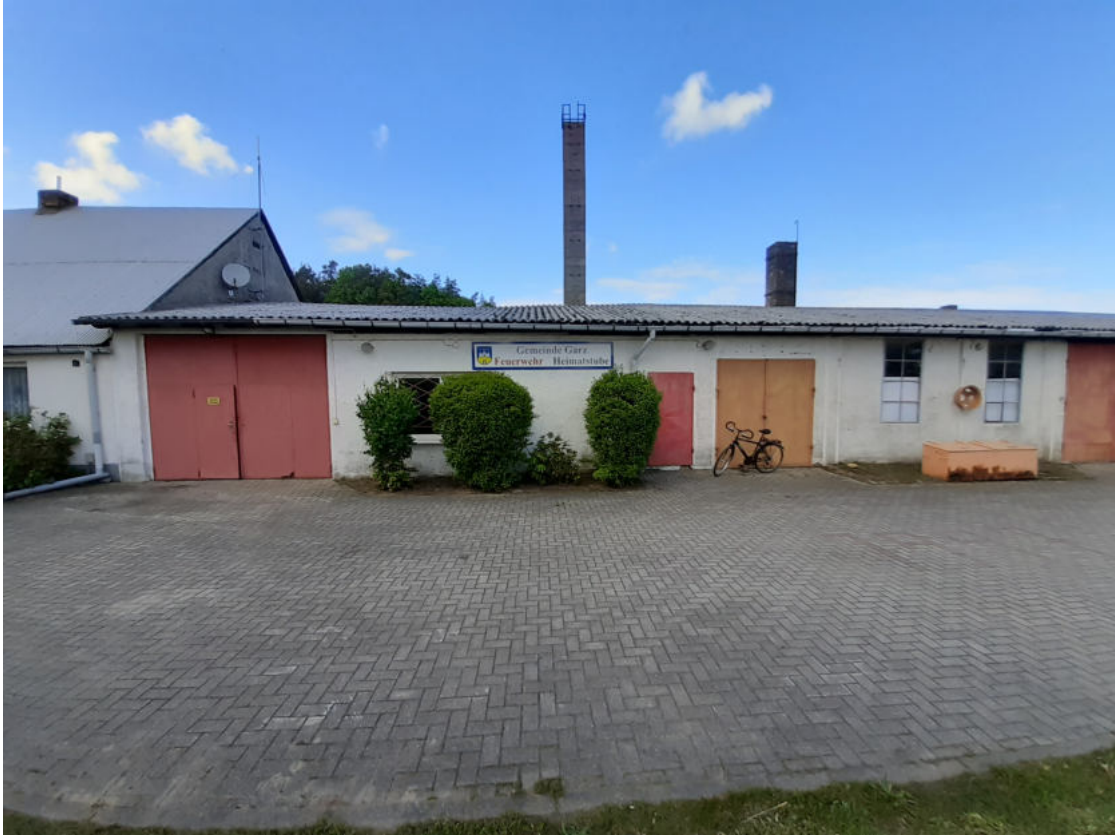
Abbildung G.2 – Außenansicht Feuerwehrhaus der Gemeindefeuerwehr Garz
