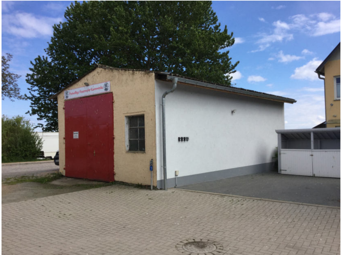
Abbildung G.2 – Außenansicht Feuerwehrhaus der Gemeindefeuerwehr Kamminke
