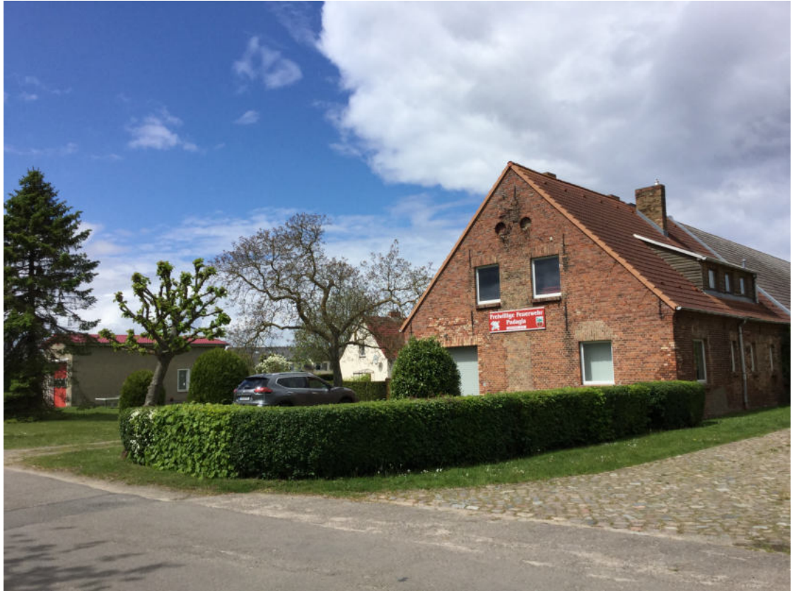
Abbildung G.2 – Außenansicht Feuerwehrhaus der Gemeindefeuerwehr Pudagla
