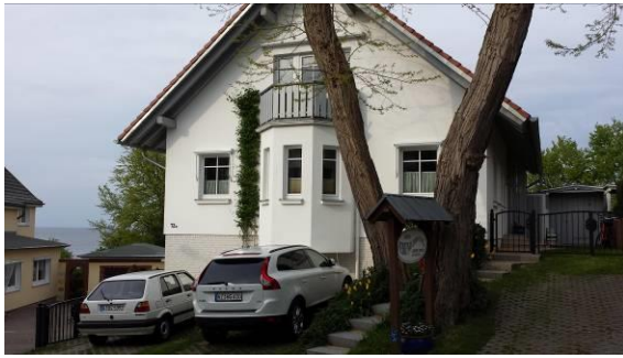
Abb. 16: Badstraße 12a Ansicht Badstraße
