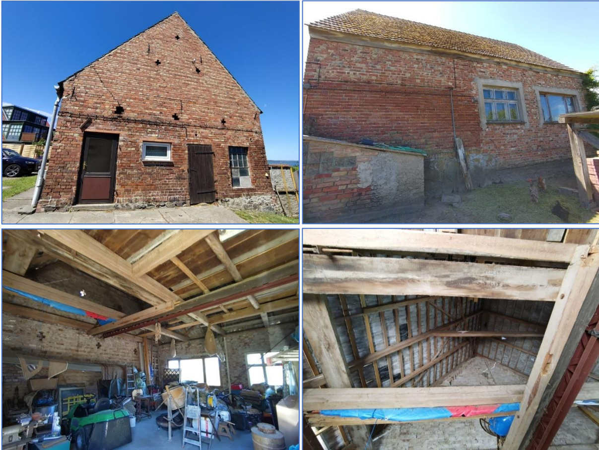
Abb. 2 bis 5 Ansichten des Gebäudes
